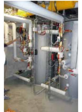
Ballons tampon des deux pompes à chaleur qui assure le préchauffage de l'ECS
